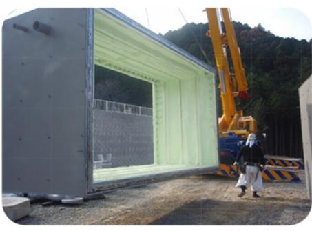
納骨室は、頑丈な地下シェルターとなっており、空調設備を完備しております。地下シェルターの工事は、兵庫県の地下室を専門に施工されている(株)B&Lさんが、ユニットの据付け・接合や内部の発泡硬質ウレタンの吹付け等を、見事な連携で行ない瞬く間に組み上がりました。
